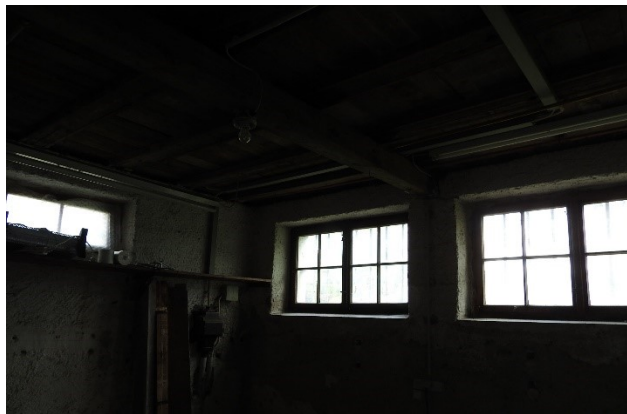
Abbildung 11: Keller mit geschlossenen Fenstern
