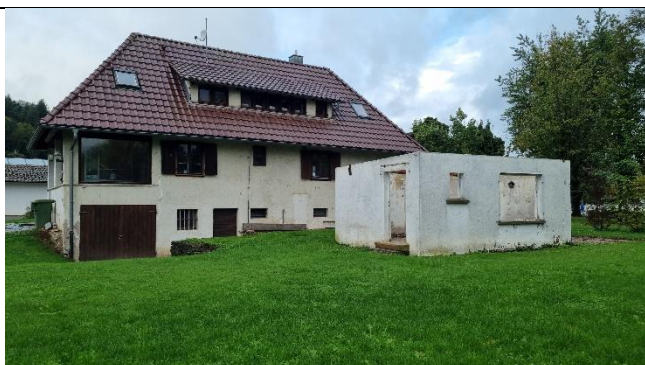
Abb. 1: Gebäude von Osten
