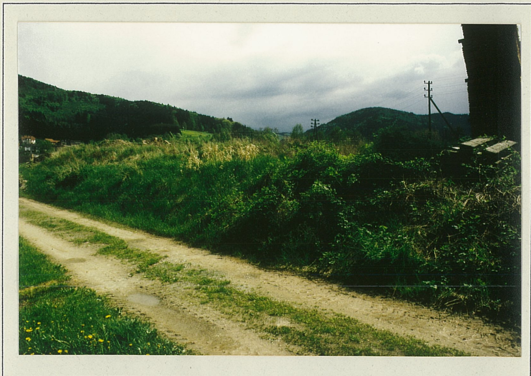
Bild 4: Böschung Gelände der Stadt Haslach (Flurst.-Nr. 1557) zum Kinzigvorland
