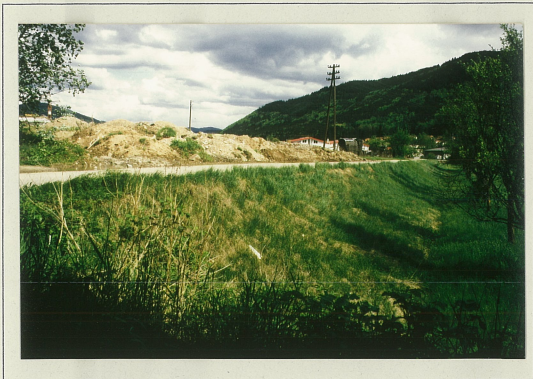
Bild 2: Böschung des alten Kinzigdammes zum Flurst.-Nr. 1560 (nicht aufgefüllt)
