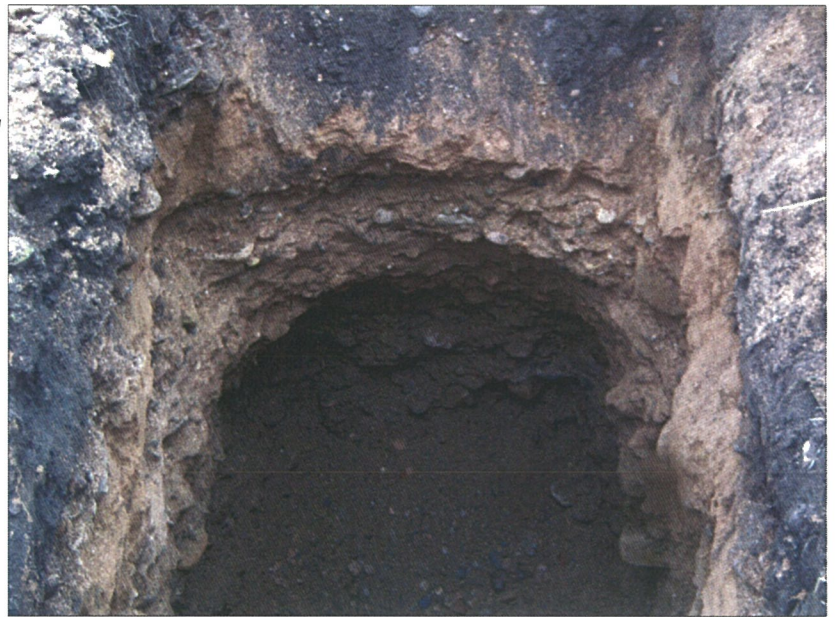
Abb. 9: Baggergut aus Schurf S 2, sandige Kinzigschotter mit Grobkies und Steinen durchsetzt
