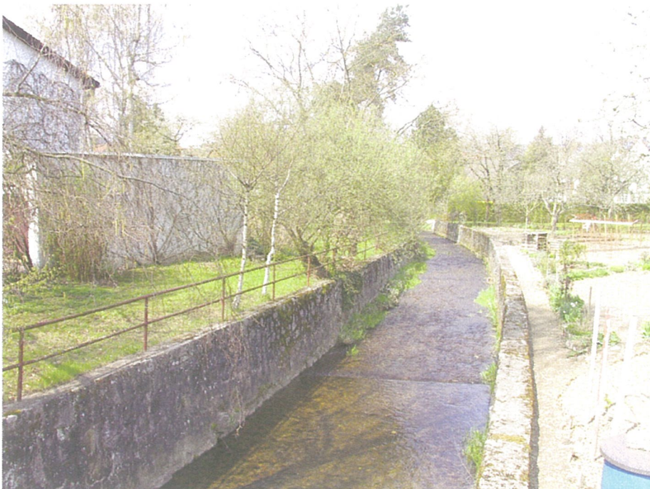
Bild 2: Hofstetter Talbach beidseitig mit Ufer- mauern befestigt (April 2004)
