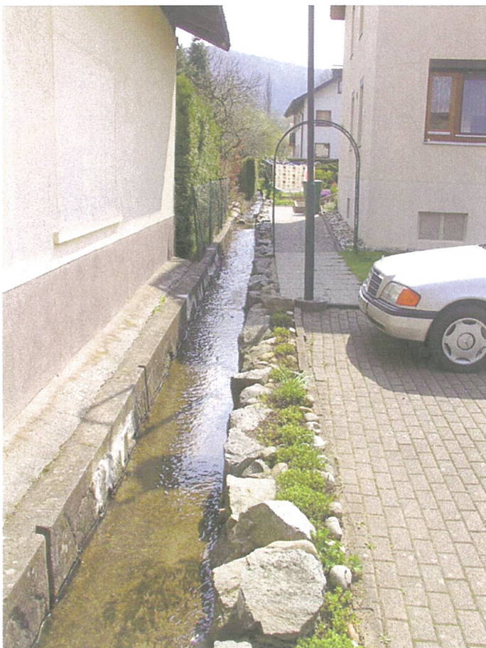
Bild 3: Kanal innerhalb des Plangebiets (April 2004)
