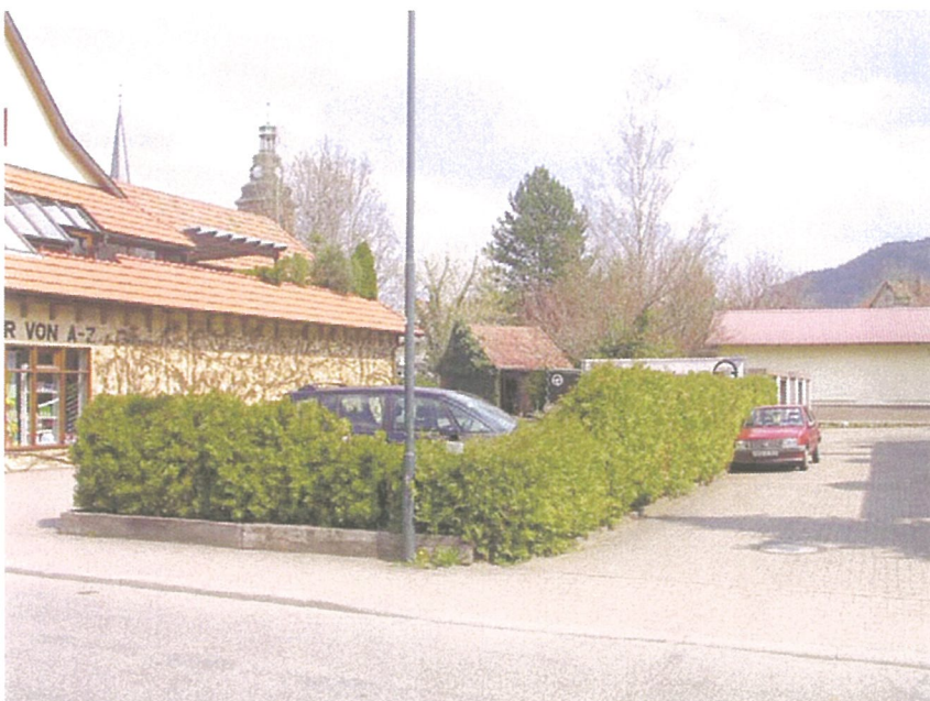
Bild 5: ein Großteil des Pla- nungsraumes ist bereits bebaut Flst.611/Wohngebäude mit Laden für Autozube- hör im Untergeschoss private Zufahrt Flst. Nr. 611/30 (April 2004)
