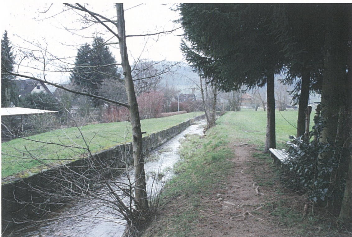
Bild 4 Bollenbach mit naturfernen Ufermauern
