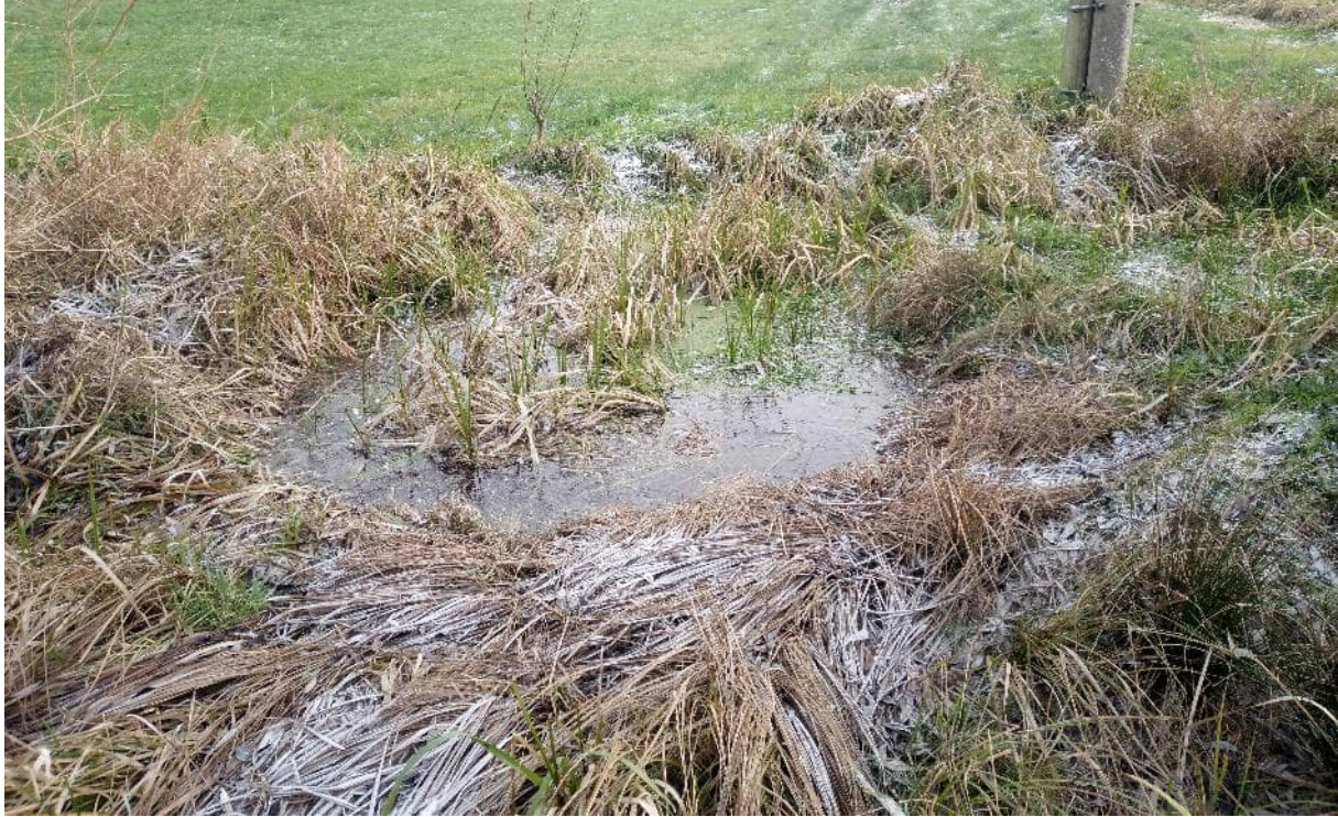
Abb. 7: Entwässerungsgraben im Zentrum des Plangebiets
