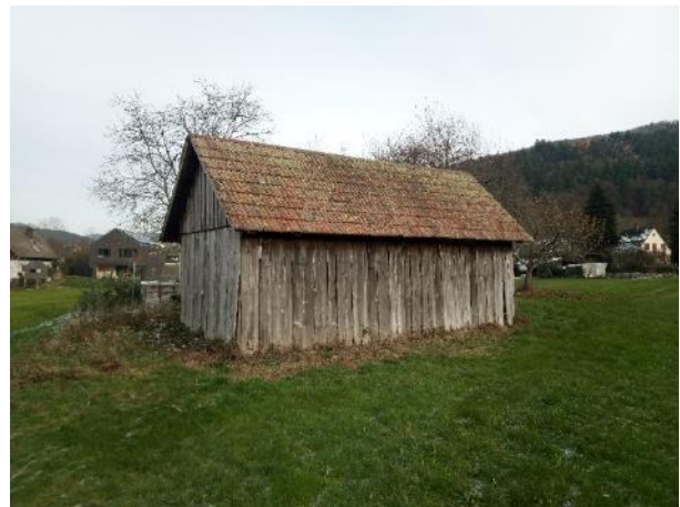
D: Schuppen im Südosten des Untersuchungsgebiet
